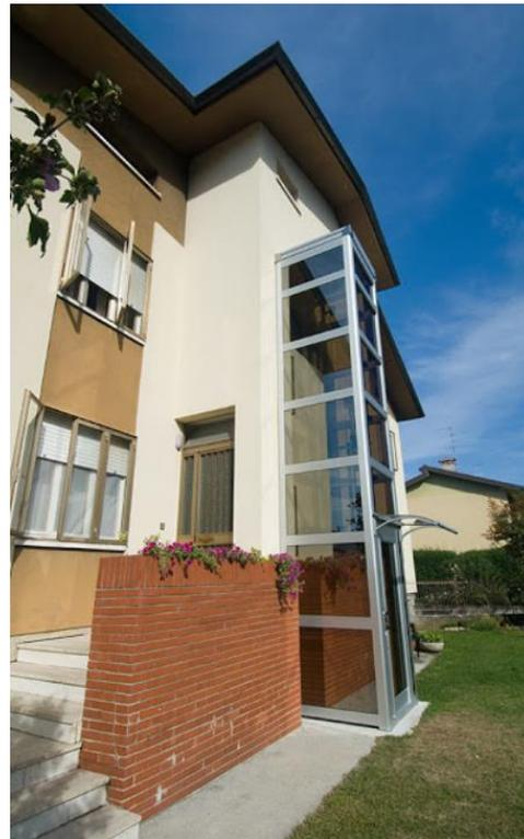
Les portes palières s'assortissent au design de la cabine, soit une porte ELSA à fermeture hydraulique (ou motorisée), ou deux portes automatiques ELETTRA, Sur demande et selon l'espace disponible, on peut aussi installer des portes coulissantes.
